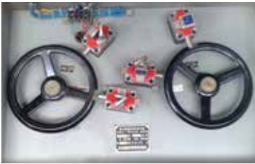
接地手轮处安装图
